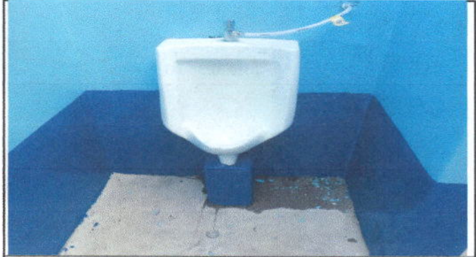
FOTO 2: Sustitución de mingitorio en módulos de baños
