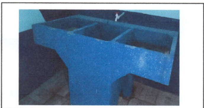
FOTO 6: Sustitución de pila de dos lavaderos en modulo de baños
