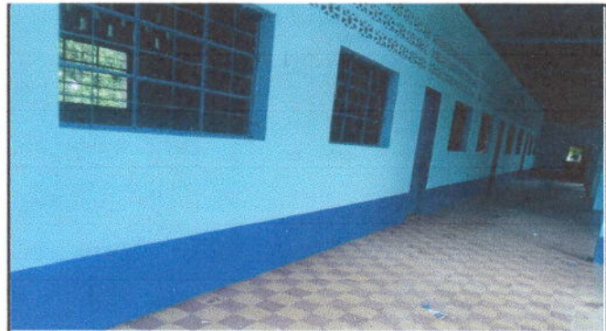
FOTO 10: Pintura en muros exteriores de aulas
