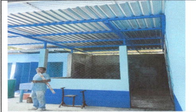
FOTO 7: Sustrucción de lámina, por lámina troquelada aluzinc calibre 26 en modulo de aula
