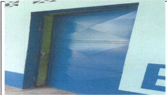
FOTO 9: Fabricación e instalación de puerta de metal en módulos de aulas
