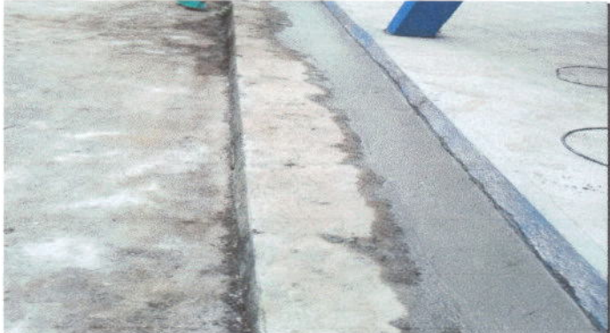
FOTO 4: Sustitución de tubería PVC línea principal aguas negras
