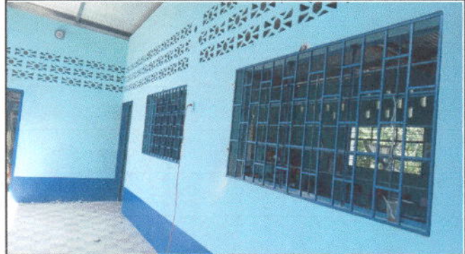
FOTO 8: Fabricación e instalación de balcones de hierro en ventana en modulo de aulas
