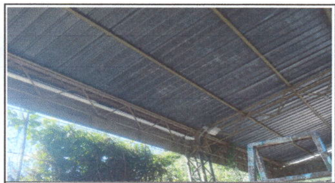
FOTO 12: Reparación de bajada de agua pluvial, tubo PVC 3"
